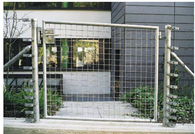
Rohrtüre in Steigung
